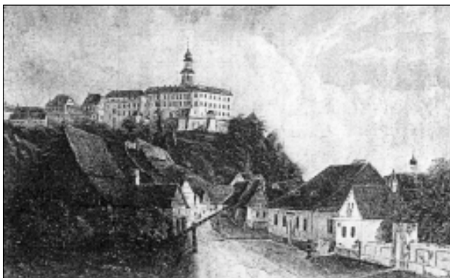
Příjezdová cesta do Náchoda se zdviženou závorou mýta
